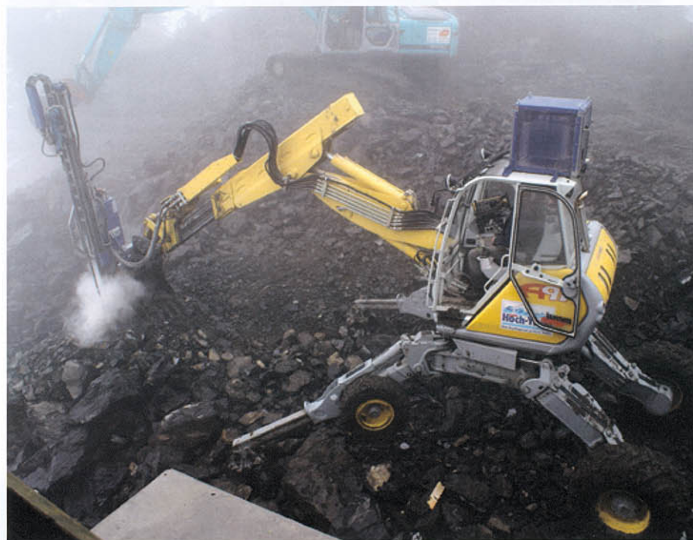
Menzi Muck „A91 avec affût de forage“ en action. Compresseur sur le toit. L'excavateur (en haut) évacue les déchets du dernier minage, les deux machines travaillent parallèlement avec efficacité.
