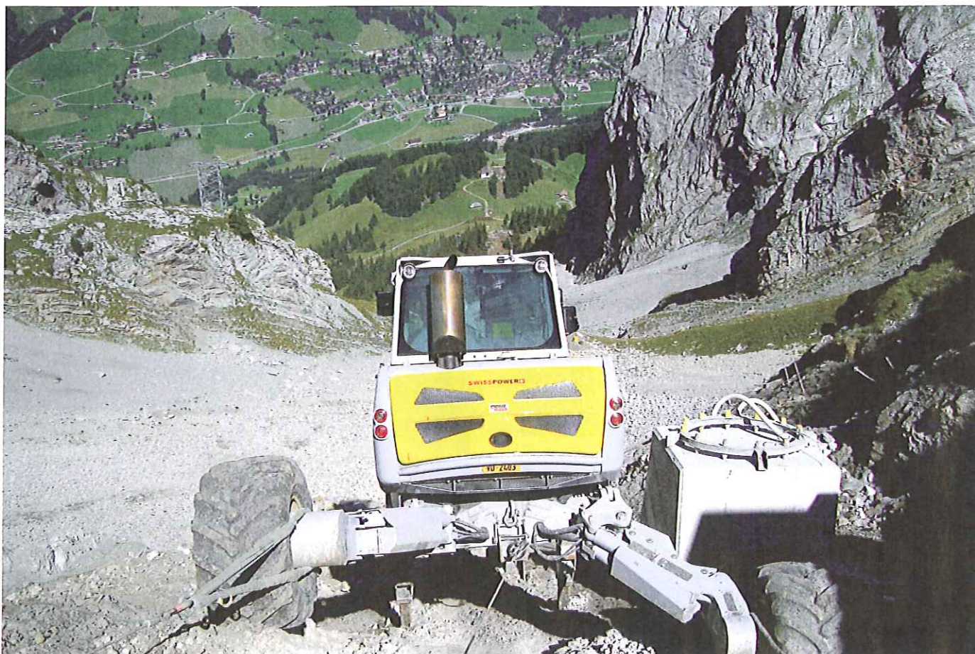
Ici, une «Menzi» d'Etienne Rouge en équilibre sur la pente abrupte de la Videmanette en-dessus de Rougemont en été 2010. L'opération consistait à creuser les trous des fondations - le long du tracé - pour les pylônes de la nouvelle télécabine.
