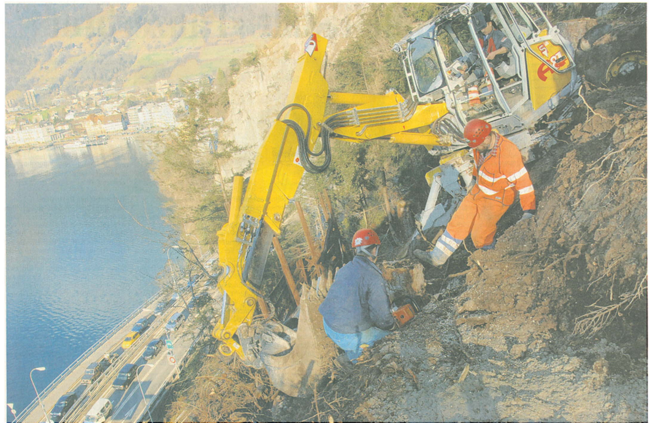
Schwindelfreiheit ist Voraussetzung: Hoch über dem See und der Fahrbahn wird an der Demontierung des alten Stahlwerkes gearbeitet.
